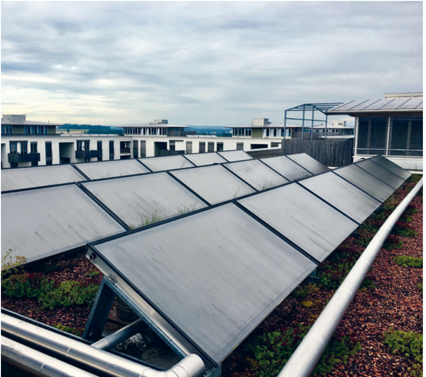
Solkollektoren-Anlage auf dem Dach in der Siedlung Klee
