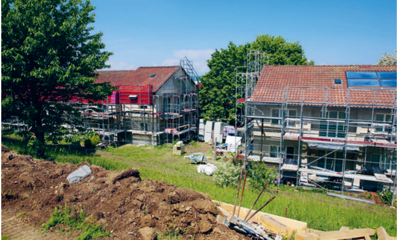
Fassadensanierung Siedlung Neuguet 2018
