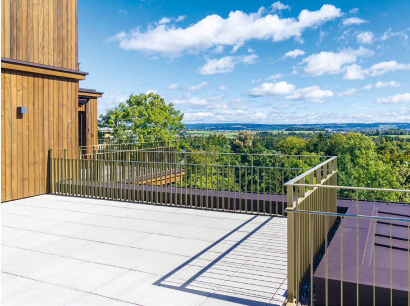
Die grosszügige, gemeinschaftlich genutzte Dachterrasse des Ersatzneubaus Lerchenhalde 60Plus bietet den Bewohner:innen einen weiten Ausblick und lädt zum Verweilen, Begegnen und Geniessen ein.
