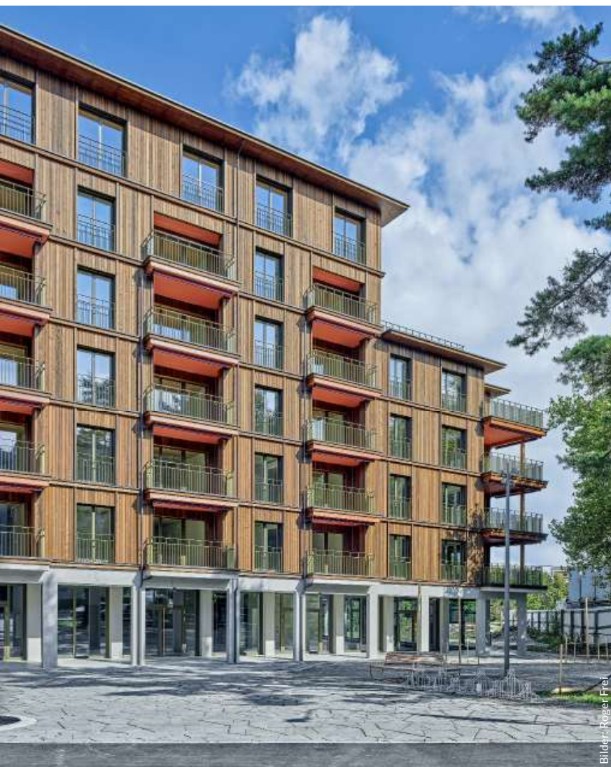
Die Fassade des Neubaus besteht aus einer vertikalen Schalung aus Tannenholz. Sie ist geschossweise durch horizontale Simse gegliedert und wird von tiefen Vordächern geschützt.
